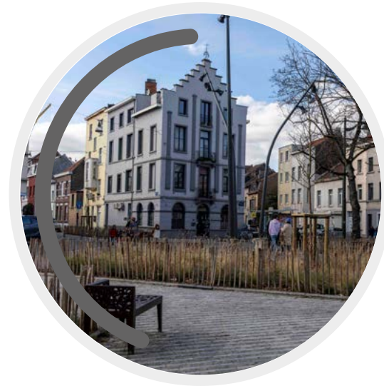
Vernieuwing van de straten en een plein in de Scheutwijk in Anderlecht
