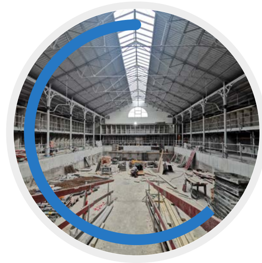
Stabiliteits- en ruwbouwwerken in het zwembad van Elsene
