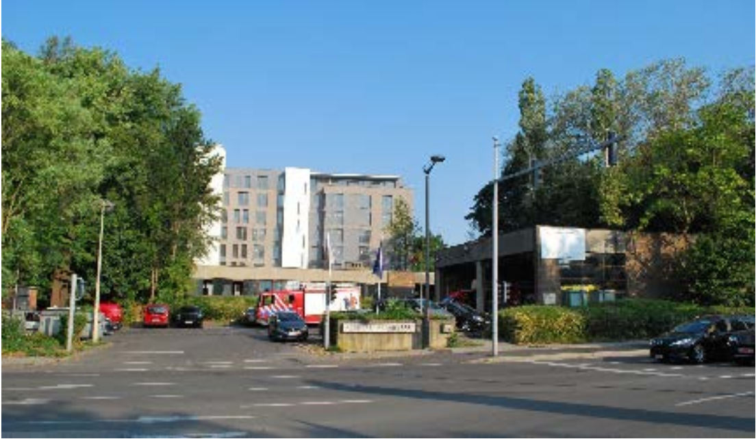
[Figure 12 : Photos de la caserne existante]
