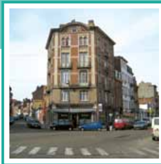
Carrefour rue V. Rauter - rue de Douvres Kruispunt V. Rauterstraat - Doverstraat
