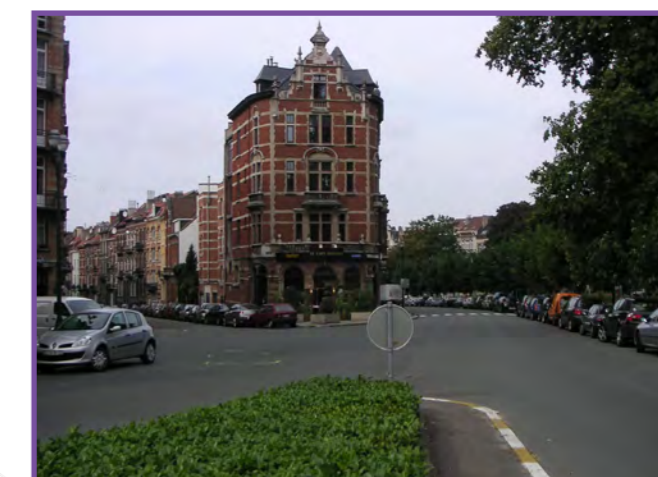
Détail 2 avant les travaux - Detail 2 voor de werken
